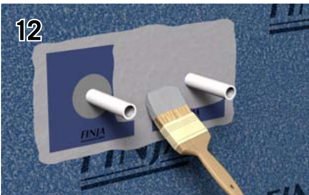
12 Montera rörmanschett för avsedd rörstorlek. Manschetterna monteras med tätmembran.
