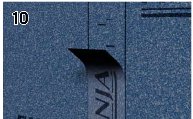
10 Fortsätt montera tätduk över hela väggen. Montera kant i kant och försegla med självhäftande tätband eller flexband monterat med tätmembran. Täck in med tätmembran.
