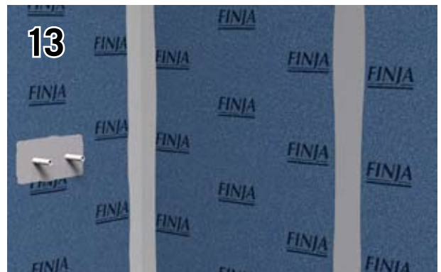
13 Försegla alla golv- och väggvinklar och hörn med tätmembran. För ökad trygghet kan även hela väggen rollas med tätmembran. Plattsättning kan utföras efter 12 timmar. Observera att torktiden kan variera beroende på temperatur och luftfuktighet.
