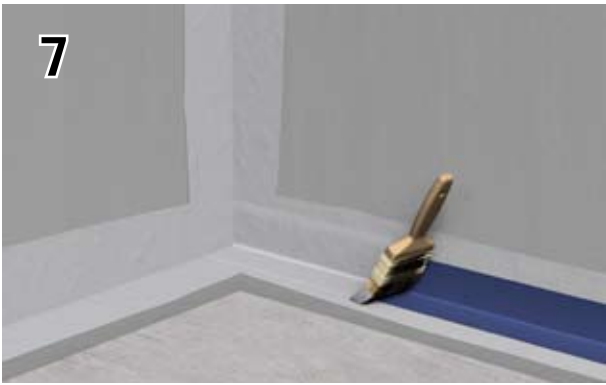
7 Försegla alla remsor med tätmembran.
